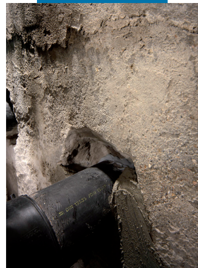
Confinamiento de Mapeproof Swell con Mapegrout
