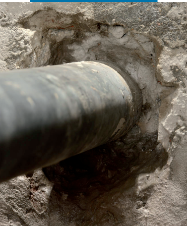
Demolición de la estructura alrededor del tubo
