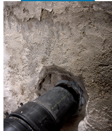
Mapeproof Swell aplicado
