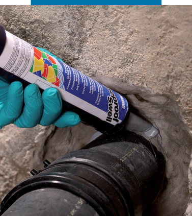
Aplicación de Mapeproof Swell alrededor del tubo
